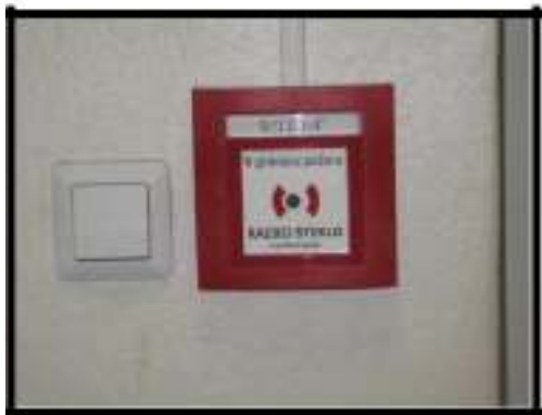
Ročni javljalnik požara
